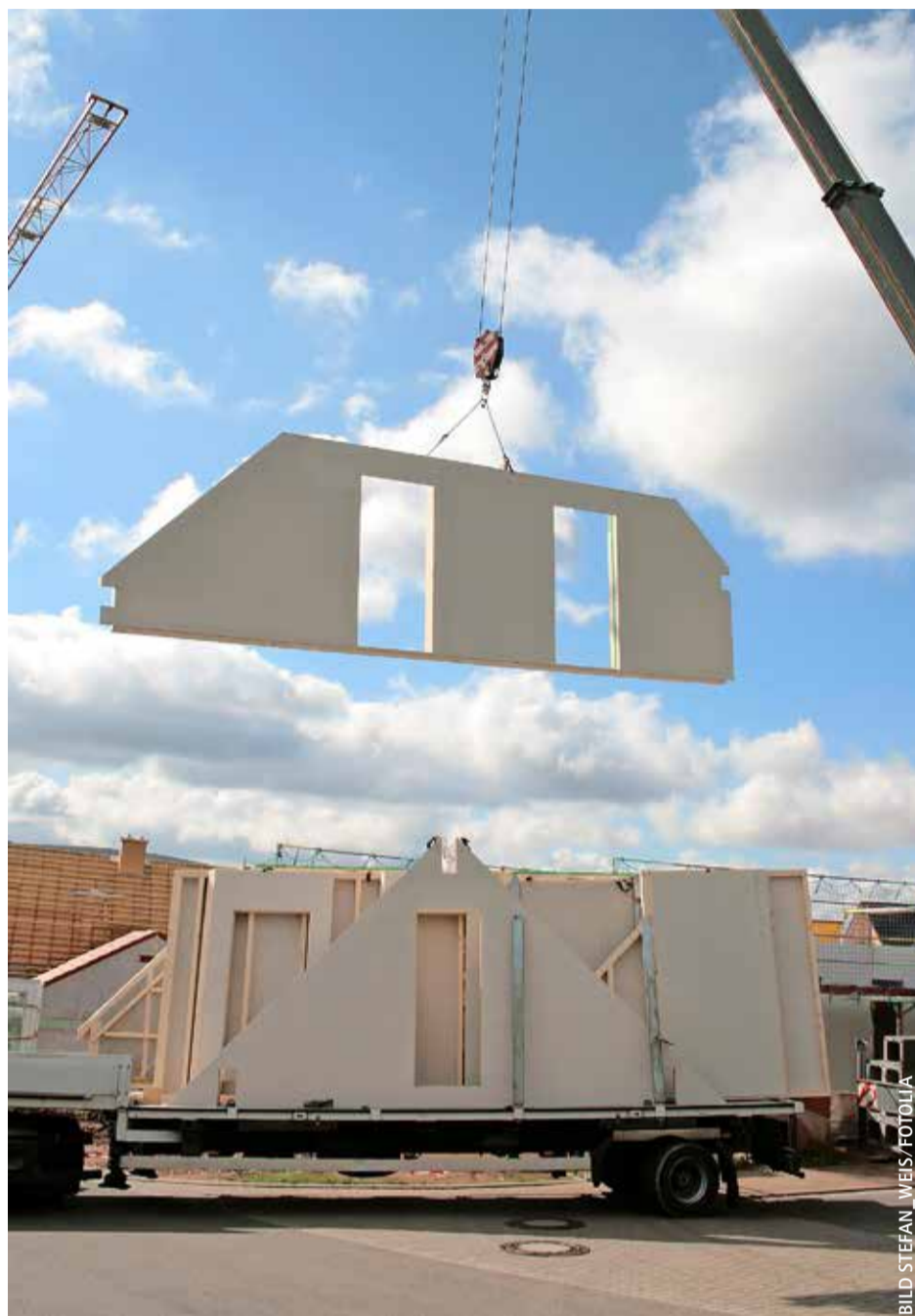
Das Fertighaus besteht oft aus standardisierten und vorgefertigten Bauteilen. Diese machen den Bauprozess gut kontrollierbar und halten die Planungskosten tief.
